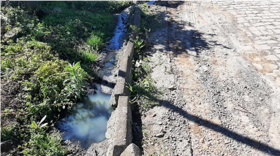
Figura 16: Ponto de vazamento da rede coletora de esgoto – SES Alto Irani 01.
