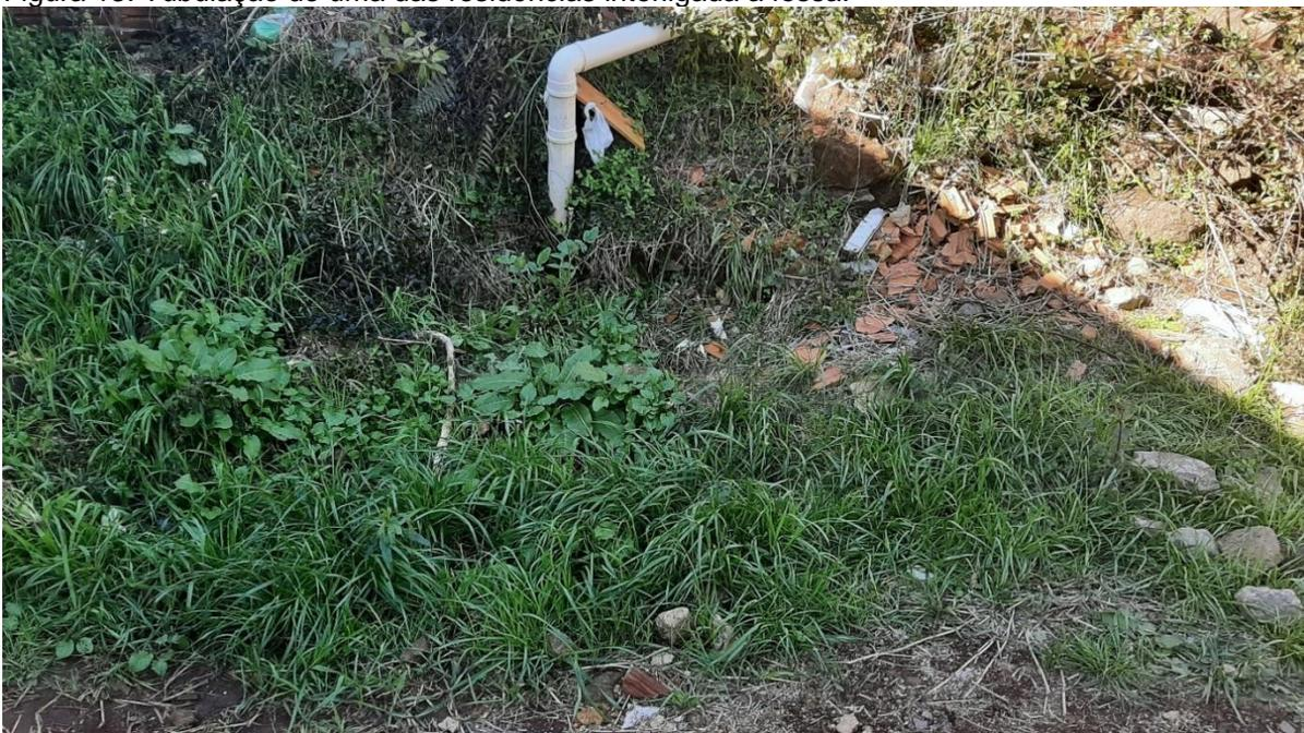
Após o tratamento, o efluente é lançado em córrego que passa ao fundo do lote onde o sistema fossa/filtro está instalado. Não há monitoramento desse sistema para avaliar sua eficiência de tratamento e os impactos causados no córrego onde o efluente tratado é lançado.
