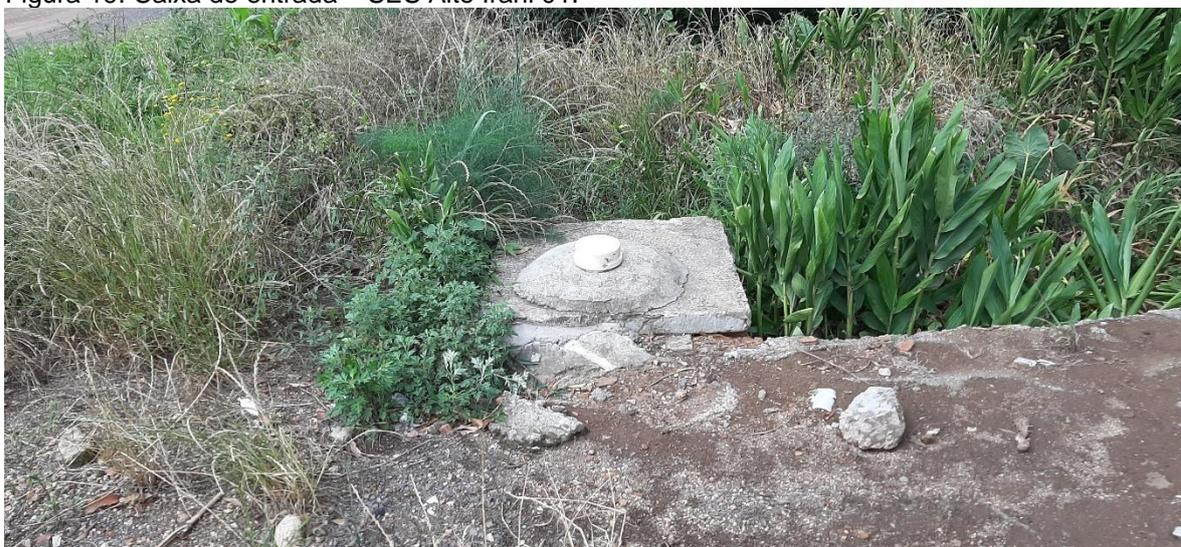
No dia da visita ao sistema (SES Alto Irani 01), observou-se a falta de limpeza e de roçada regular no entorno das unidades de tratamento. Além disso, a unidade de tratamento não possui qualquer tipo de restrição de acesso e de delimitação de área, há uma edificação muito próxima ao sistema.
